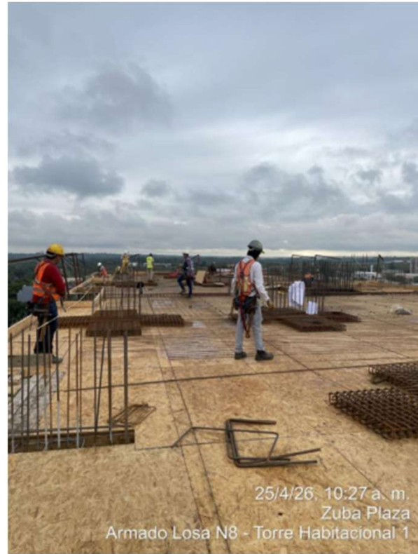
Trabajos de albañilería – Encofrado y armado de losa N8 – Fachada Torre Habitacional 1
