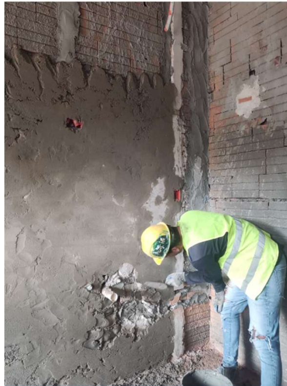
Trabajos de Instalaciones Eléctricas – Trabajos de Revoque en departamentos y pasillos
