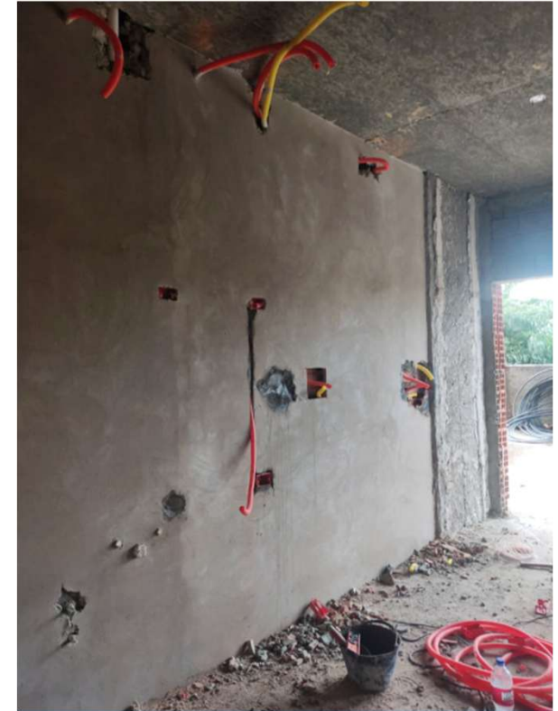
Trabajos de revoque en pasillos – Instalaciones de plomería – Trabajos de revoque e Instalaciones eléctricas
