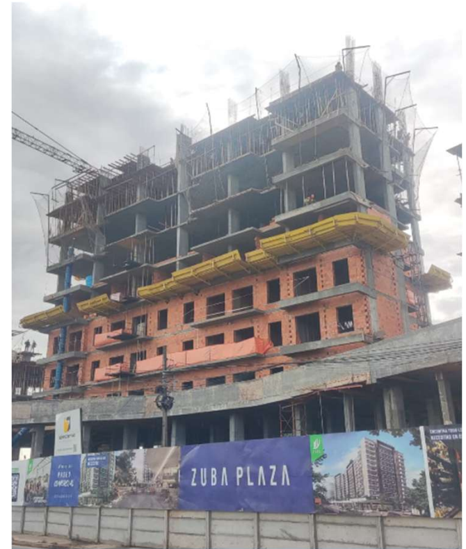
Trabajos de albañilería – Encofrado y armado de losa N8 – Fachada Torre Habitacional 1
